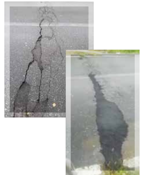
Foto: una crepa sul ponte prima e dopo l'intervento di riparazione.
